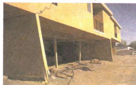
▲ شکل ۱۲- ستون‌هایی که در محل تقاطع دو و یا چند سیستم مقاوم باربر جانبی قرار دارند
