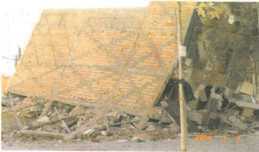
▲ شکل ۱۶- تخریب یک ساختمان به علت نادیده گرفتن اثر سختی دیوار (بم)
