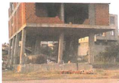
▲ شکل ۱۰- طبقه نرم به علت عدم ملاحظه سختی دیوار
