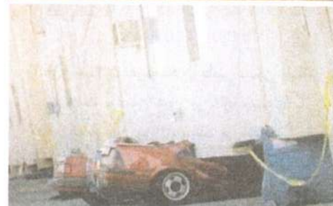
▲ شکل ۱۱- شکست طبقه نرم در زلزله
